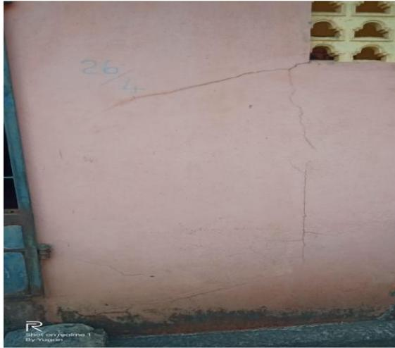
**FIG (2-B) CRACKS IN THE EXTERIOR WALL HEAVING**
